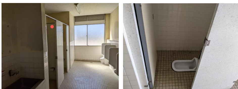
普通・特別教室棟 2 階男子便所 (1)
