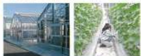
IT型環境制御温室
