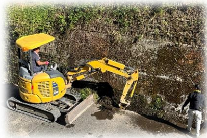
重機による校舎裏の溝掃除
