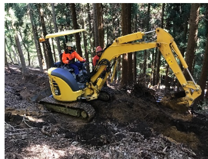
【バックホーによる敷設実習】
