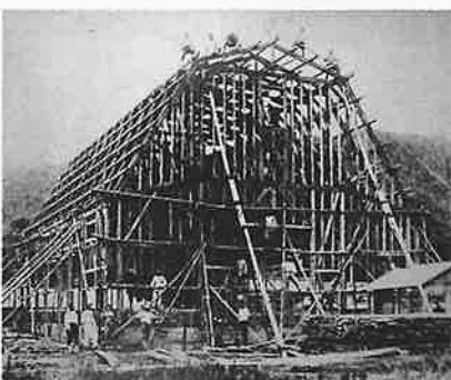
建設中のマンサード型の講堂兼体育館。(大正15年)
