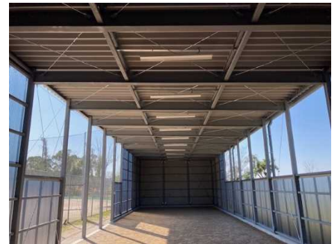
室内練習場内部
