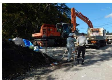
建設現場での測量
