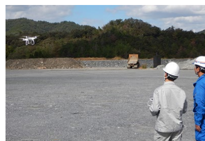
建設現場でのドローン操作
