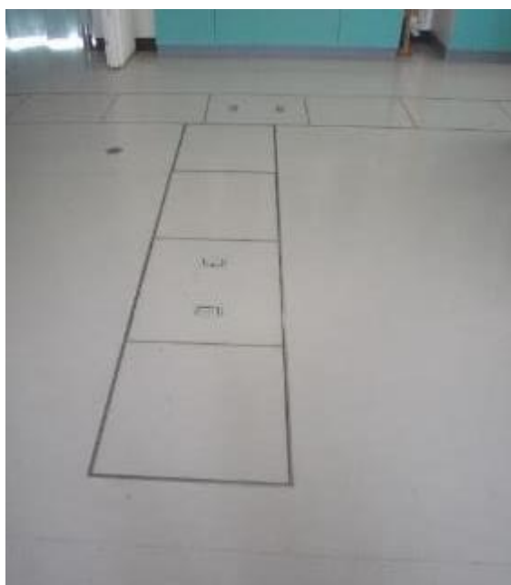
【設置予定場所（配管工事済）】
